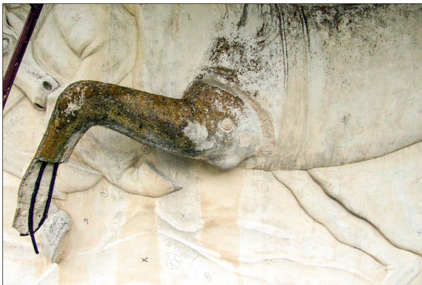
Obr. 31. Nevhodný doplněk renesanční vápenné štukatury provedený z cementové malty, patrná je také zkorodovaná armatura, která doplněk nohy roztrhla. (SZ Telč, Plutonovo čtyřspřeží, stav před restaurováním v letech 2014–2015. Foto: Jana Waissarová)
