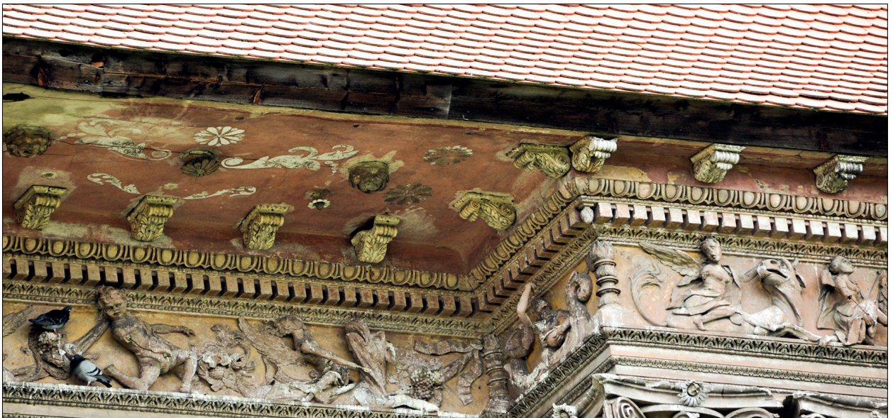
Obr. 17. Plumloov, zámek, severní fasáda. Snímek korunní římsy s litými štukovými konzolami, bohatě dekorovaným vlysem a dalšími sériově zhotovovanými architektonickými prvky ze štuky (hlavice pilastrů, vejcovce). Foto: Petr Kuneš.
