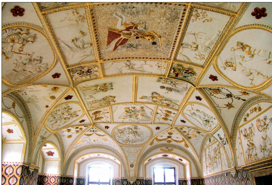
Obr. 45 a 46. Četné mladší novodobé doplňky a nevhodné povrchové úpravy štukové výzdoby sálu postupně výrazně pozměnily jeho původní výtvarné působení. (SZ Kratochvíle, Zlatý sál, nahoře stav před posledním restaurováním, dole po restaurování z let 2005–2011, které nahradilo starší doplňky, obnovilo dochované povrchy štukatur včetně zlacení a odlišitelným způsobem rekonstruovalo doložitelné zlacení a polychromii. Foto: Jana WeissEROVÁ)
