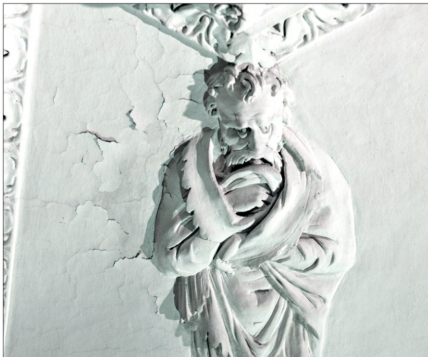
Obr. 37. Nekompatibilní, značně pojený druhotný nátěr se plošně odděluje od štukatury. Vrstva nátěru i v tomto případě zaslepuje původně ostře zpracované partie modelace, které záměrně kontrastovaly s měkcou modelací jiných částí. (Praha, letohrádek Hvězda, 2019. Foto: Petr Kuneš)
