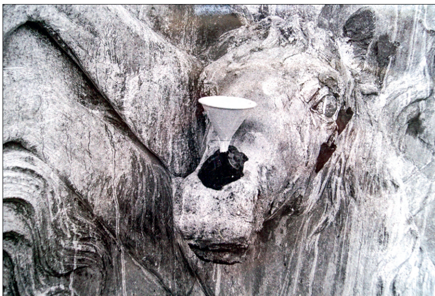
Obr. 32. Původní prvek na bázi vápenného štuku byl v minulosti doplněn a plošně přetažen pevným a málo prodyšným cementovým tmelem, který způsobuje další degradaci originálu. Stav originálu a neznalost jeho původního tvaru pravděpodobně nedovolily přesnější rekonstrukci, výsledkem je tak pouze hrubě naznačená forma původního prvku, který však po zásahu trpí. (SZ Jindřichův Hradec, portál Adamova stavení, stav v roce 2020. Foto: Vojtěch Krajíček)
