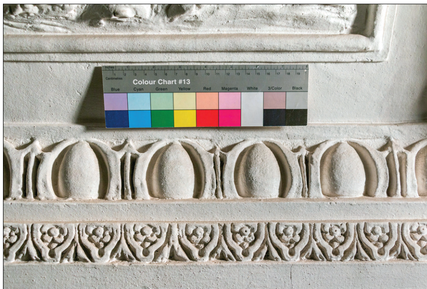
Obr. 18. Praha, letohrádek Hvězda, sál Aenea. Vejcovce a listovce zhotovený vytlačováním (kvečováním) vápenného štku formou. Foto: Kateřina Krhánková.
