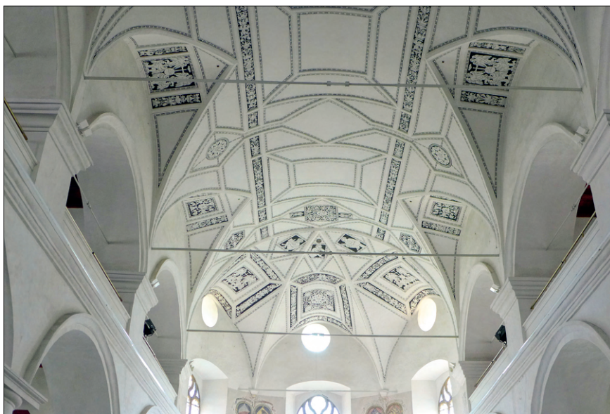
Obr. 43. Celková rekonstrukce štukové renesanční klenební sítě se sgrafitovou ornamentální výzdobou vychází z původního renesančního rozvrhu, ale materiálově ani technologicky původnímu provedení neodpovídá – štuky jsou provedené v cementové maltě a sgrafito znázorněno kontrastní černobílou malbou. (Mladá Boleslav, Sbor jednoty bratrské, klenba lodi kostela byla obnovena na počátku 20. století na základě dochovaných otisků štukových žeber; k destrukci většiny původní renesanční výzdoby došlo po r. 1787, kdy byl kostel přeměněn na vojenské skladiště, stav v roce 2018. Foto: Paola Mikešová)
