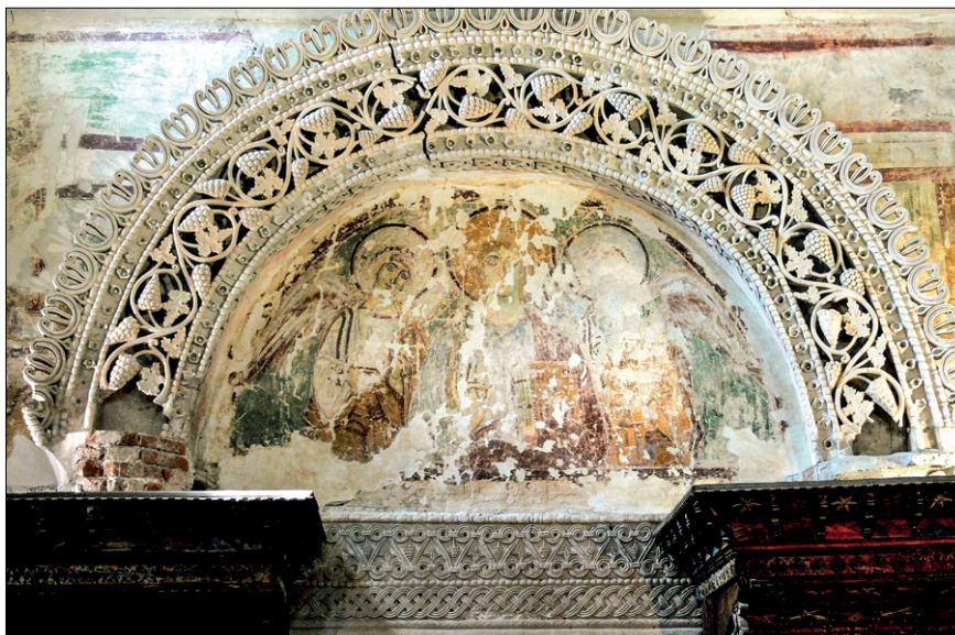
Obr. 4. Cividale del Friuli (Itálie), Kostel Panny Marie zvaný Tempietto Longobardo, štukový rámec západního portálu, 8. století. Jediněčná štuková výzdoba středověkého langobardského stylu. Původně byl štuk částečně barevně dekorován. Zdroj: commons.wikipedia.org.
