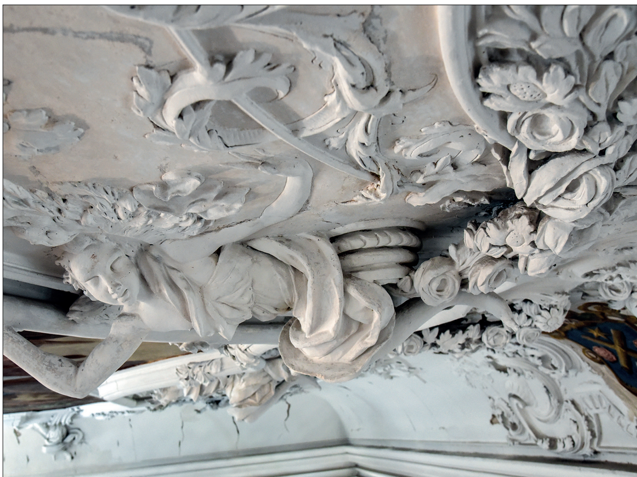
Obr. 16. Plasy, prelatura kláštera. Barokní štuková výzdoba stropu s polopostavami vystupujícími do prostoru, složitě komponovanou, osazovanou i na místě modelovanou vegetační výzdobou. Foto: Petr Kuneš.
