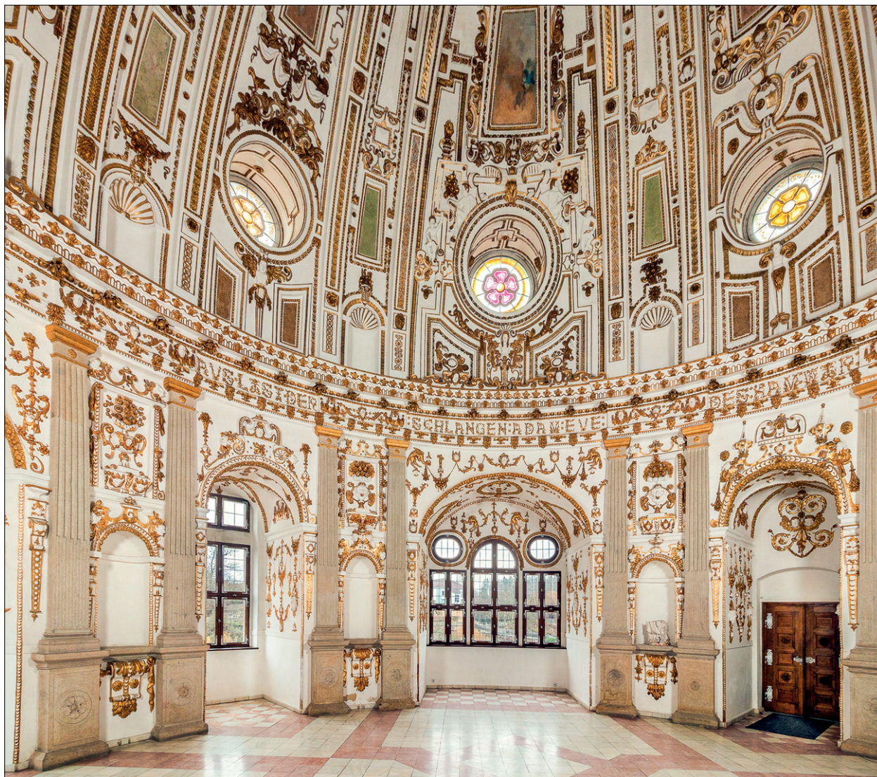
Obr. 44. Posun celkového ztvořnění interiéru a rozvrh zlacených částí štukatur vytvořil dřívě neexistující novotvar, neboť nerespektuje poznatky o starších podobách památky, které byly doložené předcházejícím restaurátorským průzkumem. Původní rozsah zlacení byl dle průzkumů podstatně méně dominantní a pouze akcentoval určité detaily výzdoby. (SZ Jindřichův Hradec, Rondel, stav interiéru v roce 2019 odrážející celkovou obnovu ze 70. a 80. let 20. stol., rozsah i provedení zlacení bronzí v olejovém pojivu byly předmětem sporů již v době realizace zásahu. Foto: Vojtěch Krajiček)
