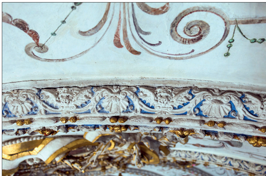
Obr. 27. Bučovice, zámek, Císařský pokoj, výzdoba žeber klenby. Odlučování jednotlivých dílů výzdoby v místech napojení vytlačovaného štukového dekoru.
